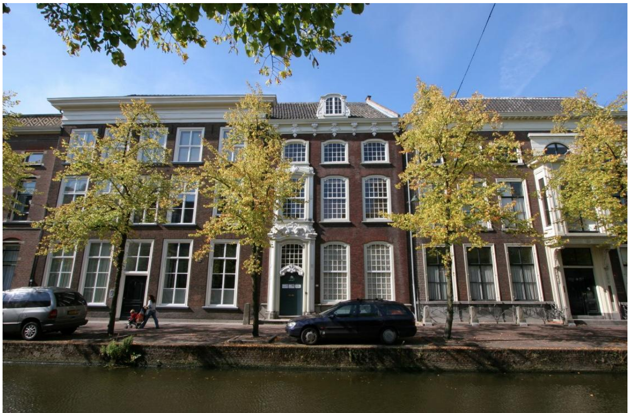
Voorbeeldproject Huis de Witte Roos: de 18 e eeuwse voorgevel met kleinschalig ruitenpatroon aan de Oude Delft, na restauratie.
